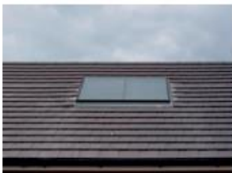
C. CAPTEURS PHOTOVOLTAÏQUES INTÉGRÉS DANS UNE COUVERTURE EN TUILES
