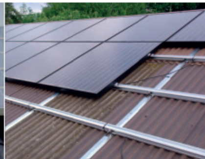
Fig. 4 Fixation des capteurs solaires sur des plaques ondulées.
