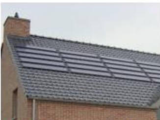
Fig. 2 Intégration des capteurs dans une toiture inclinée.
