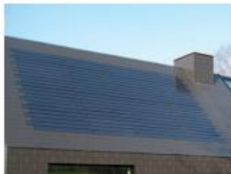
D. CAPTEURS PHOTOVOLTAÏQUES INTÉGRÉS DANS UNE COUVERTURE EN ARDOISES
