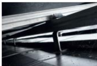
Fig. 8 Encadrement de la tuile par le crochet et tuile métallique sous le crochet de fixation.
