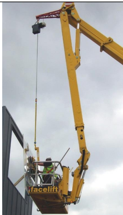
Fig. 5-13: Nacelle avec dispositif de levage intégré en bout de flèche
