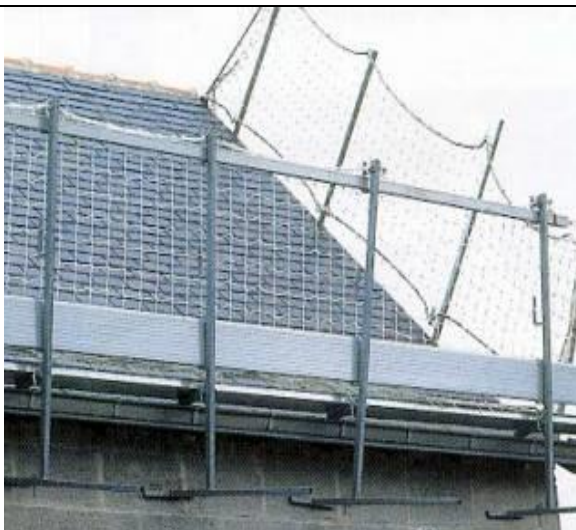
Fig. 5-9: protection par filet périphérique en rive et versant de toiture
