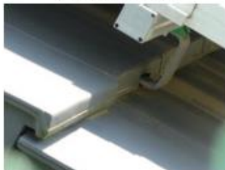
Fig. 9 Adaptation d'une tuile au passage du crochet.
