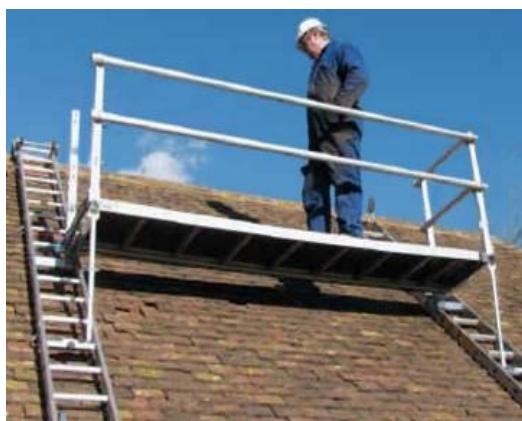
Fig. 5-10: dispositifs d'arrêt de chute en toiture
