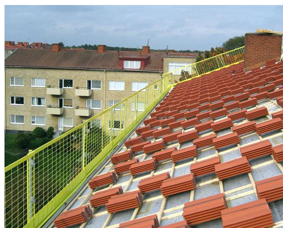
Fig. 5-10: dispositifs d'arrêt de chute en toiture
