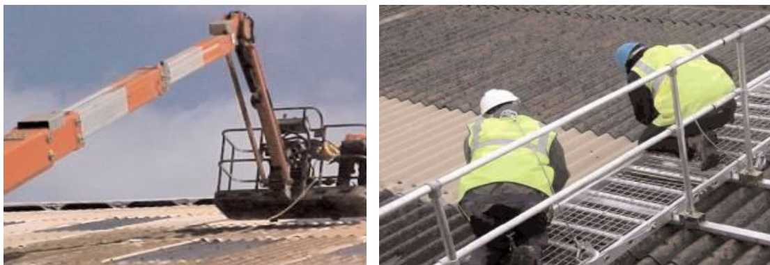
Fig. 5-12: utilisation d'une nacelle ou d'une passerelle mobile
