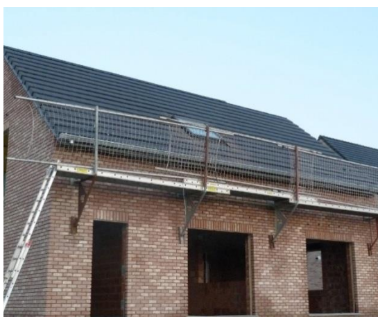
Fig. 5-10: dispositifs d'arrêt de chute en toiture
