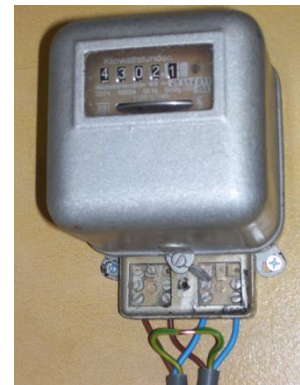
Fig. 4-20 : compteurs CV mécaniques
