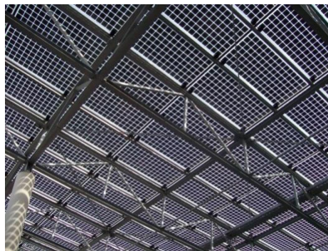
Fig. 3-45 : pose en atrium société Solarwatt – Dresden (D)
