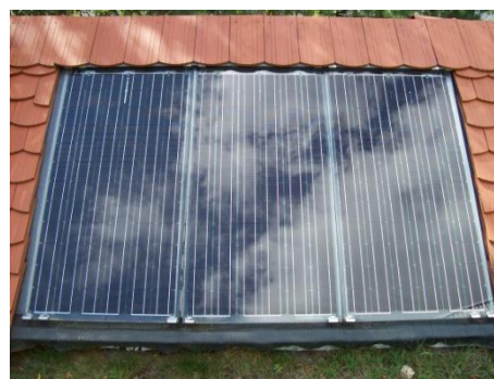
Fig. 3-40 : installation en intégration
