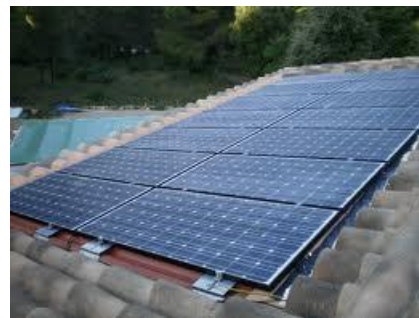
Fig. 2-4-2 : modules photovoltaïques monté sur toiture inclinée
