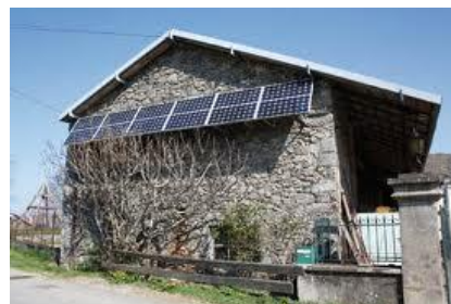
Fig. 2-3 : modules photovoltaïques monté sur pignon
