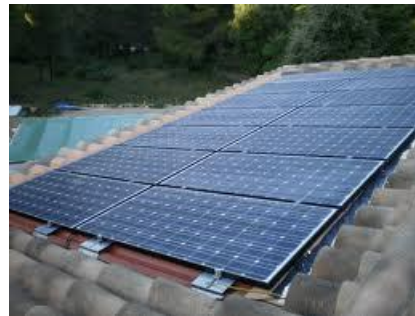
Fig. 2-1 : modules photovoltaïques monté sur toiture inclinée
