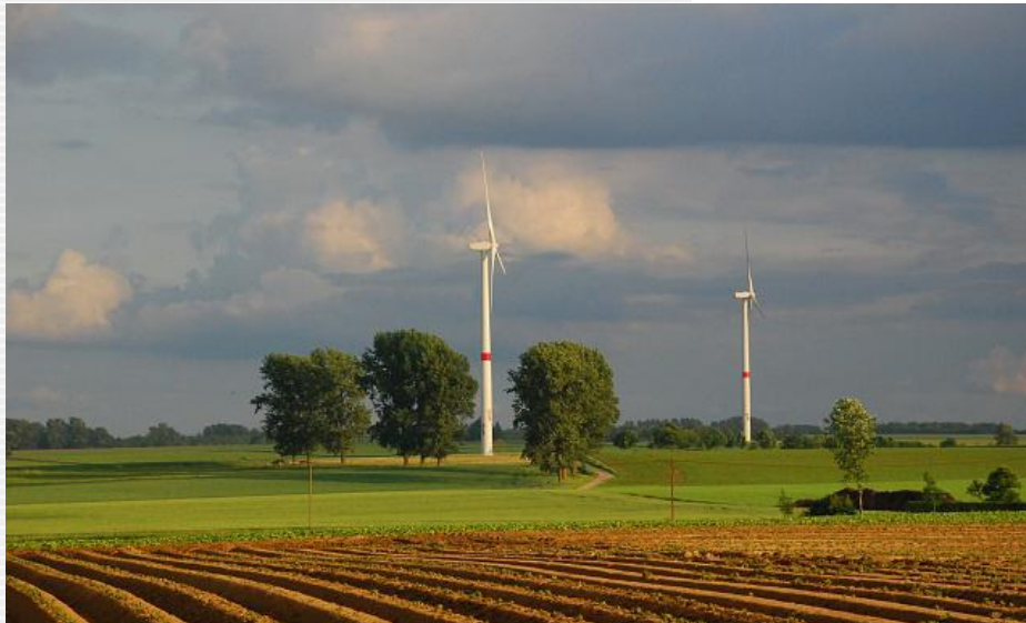
Éoliennes de Perwez (source: APERe)
