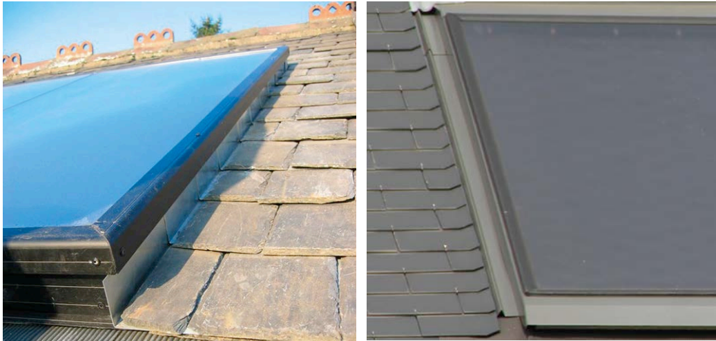
Fig. 41 Raccord de type noquet (à gauche) et raccord continu (à droite).
