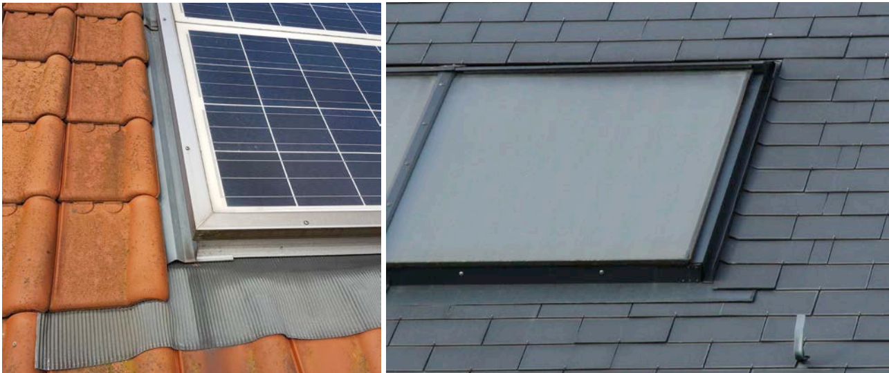
Fig. 46 Recouvrement en aval à l'aide d'une feuille métallique.
