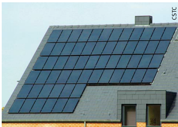
Fig. 10 Capteurs solaires photovoltaïques en semi-intégration.
