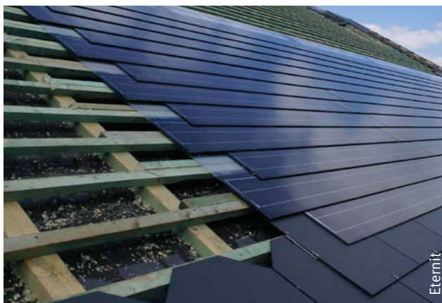
Fig. 8 Capteurs intégrés aux éléments de couverture et vue d'ensemble d'une installation photovoltaïque intégrée à la toiture.
