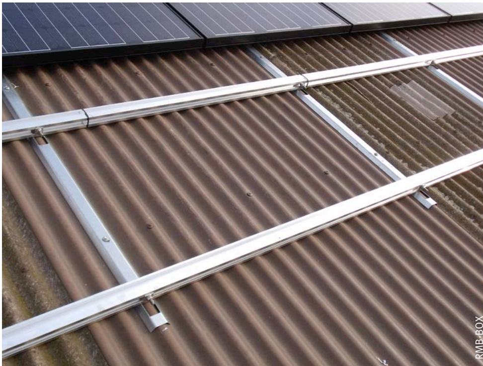
Fig. 18 Autre dispositif de fixation pour plaques ondulées et tôles profilées.
