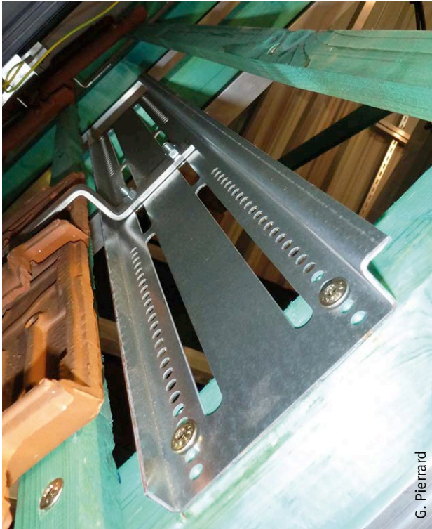
Fig. 25 Crochet situé sur un rail coulissant.
