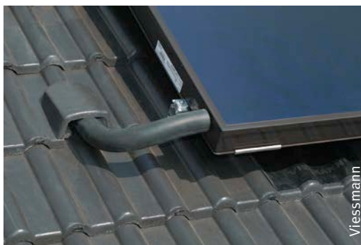
Fig. 50 Accessoires spécifiques pour le passage de câbles et de conduits.
