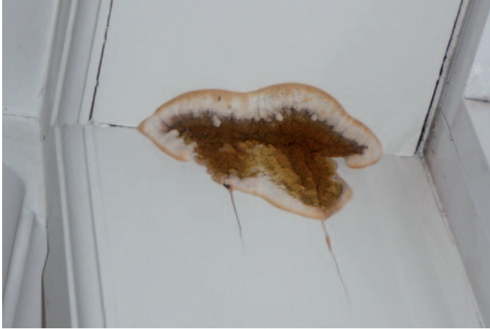
Fig. 52 Attaque de champignon en pied de versant ▲ Mur endommagé par des poussées latérales ►
