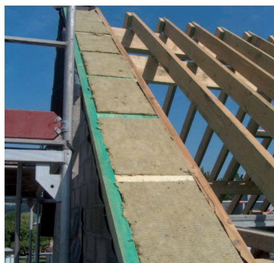
Fig. 33 Isolation de l'échelle de toit.
