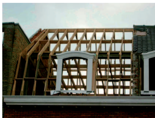
Fig. 55 Pose d'une nouvelle charpente lors d'une rénovation de toiture.
