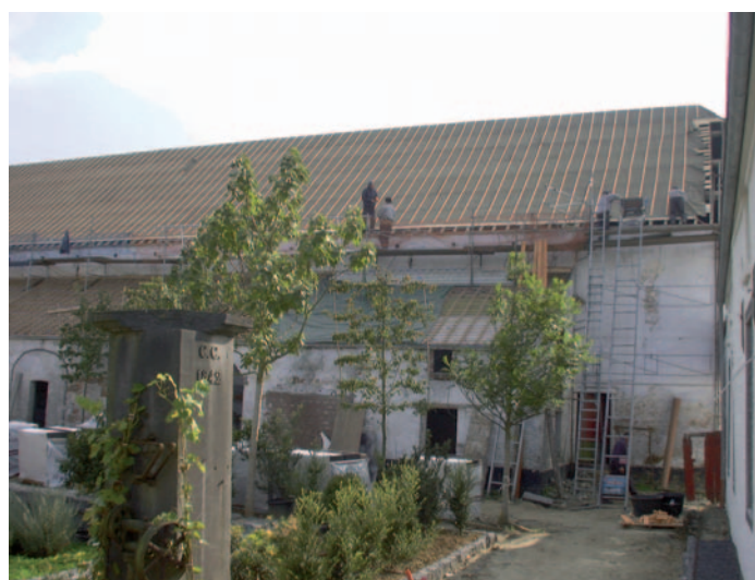
Fig. 53 Rénovation d'une couverture en tuiles.
