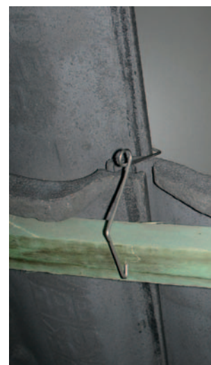
Fig. 25 Crochet dans l'emboîtement latéral.
