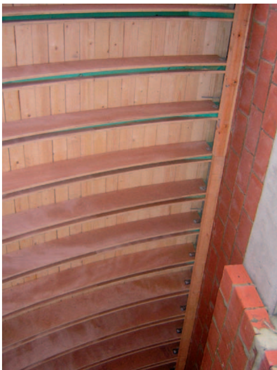
Fig. 49 Exemple d'exécution d'un support de toiture cintrée.
