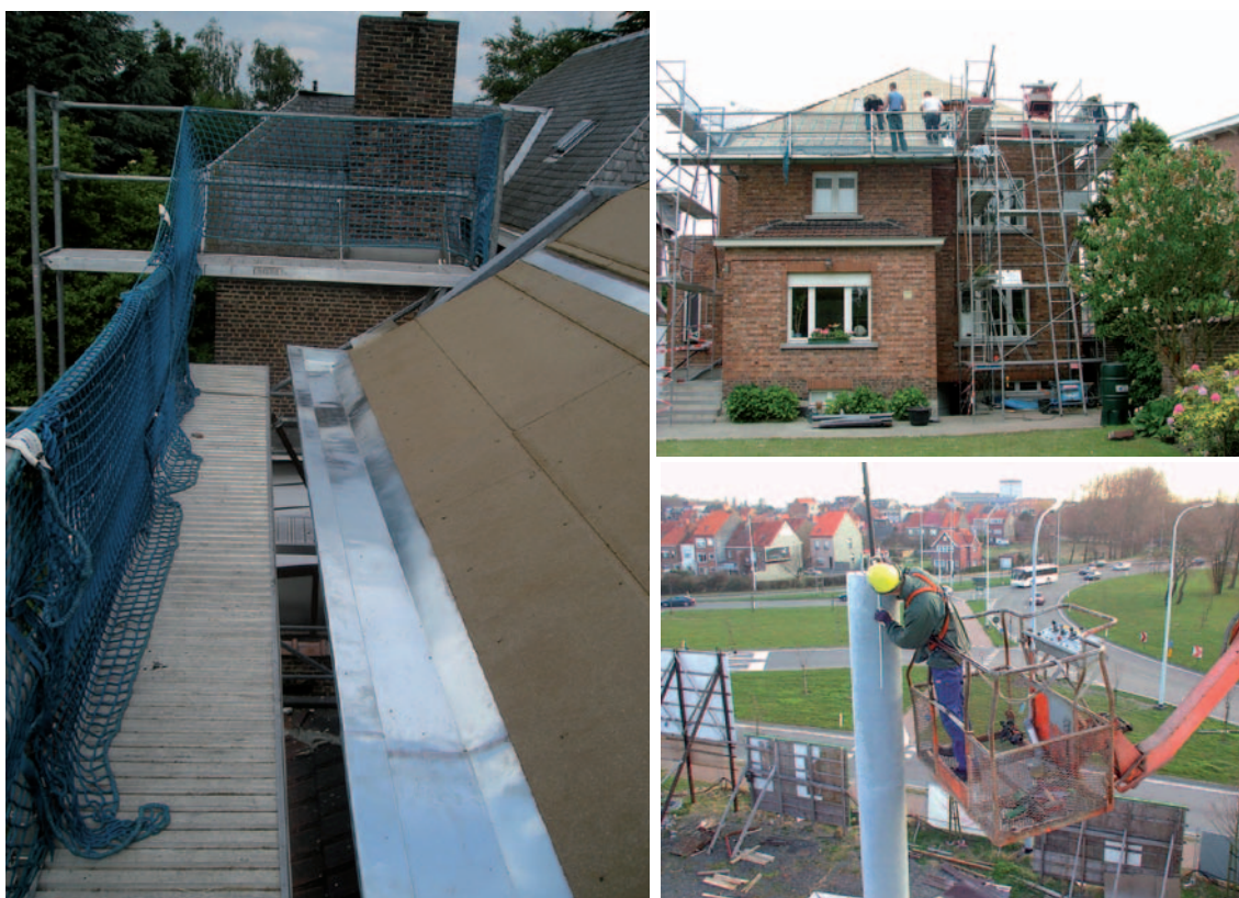
Fig. 60 Exemples de protection collective. A gauche et en haut à droite, échafaudages établis au sol. En bas, à droite, nacelle.
