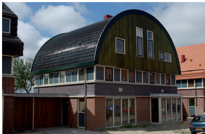
Fig. 46 Toiture en plein-cintre.
