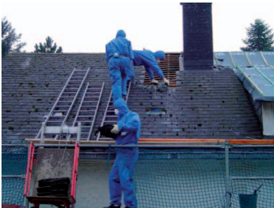
Fig. 54 Enlèvement d'ardoises en amiante-ciment selon la réglementation fédérale en vigueur.
