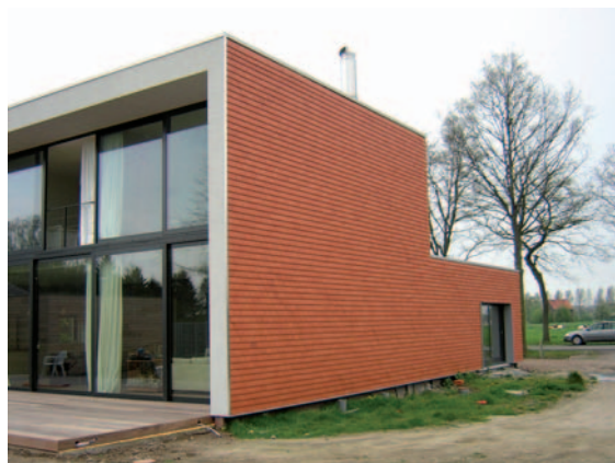
Fig. 57 Rénovation d'un bâtiment au moyen d'un bardage en tuiles (vues avant et après rénovation), lui offrant un aspect totalement neuf.
