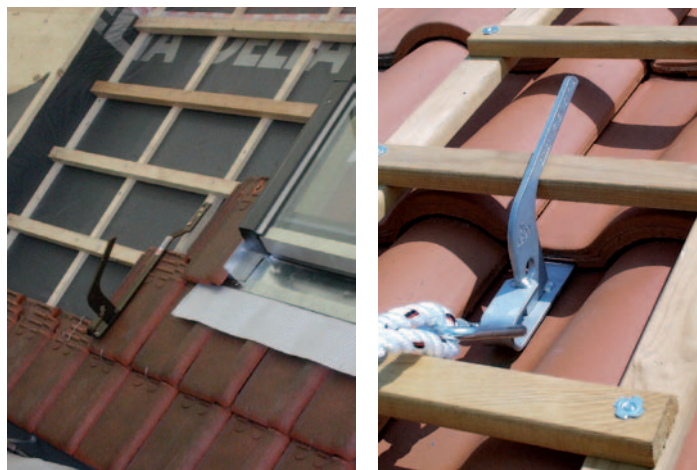
Fig. 27 Exemples de crochets de sécurité.
