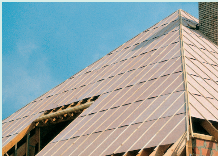
Fig. 8 Sous-toiture sous forme de plaques en fibres-ciment.
