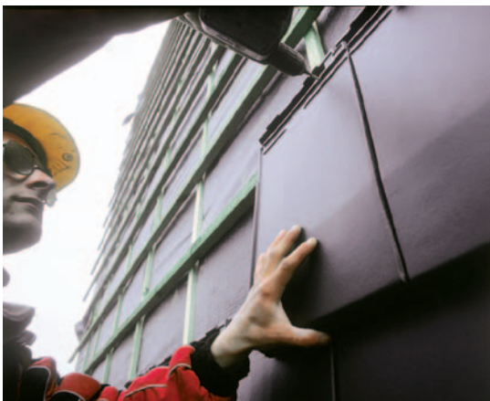
Fig. 45 Fixation des tuiles sur un versant vertical.
