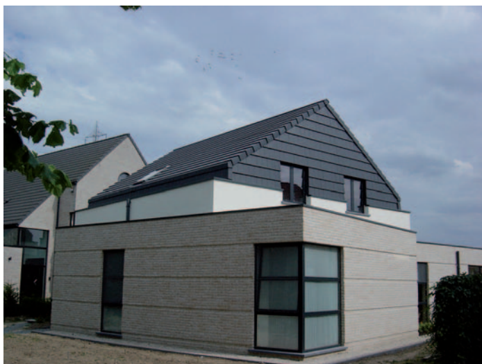
Fig. 42 Exemple de bardage en tuiles.
