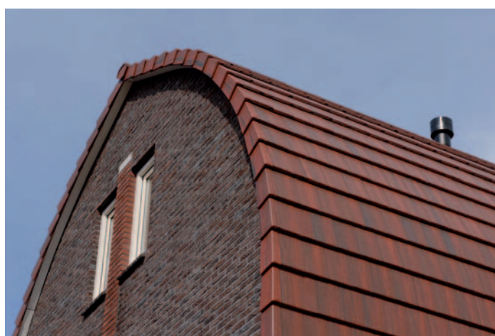
Fig. 47 Toiture cintrée de type ogival.
