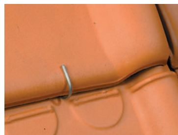
Fig. 24 Crochet dans l'emboîtement de tête.
