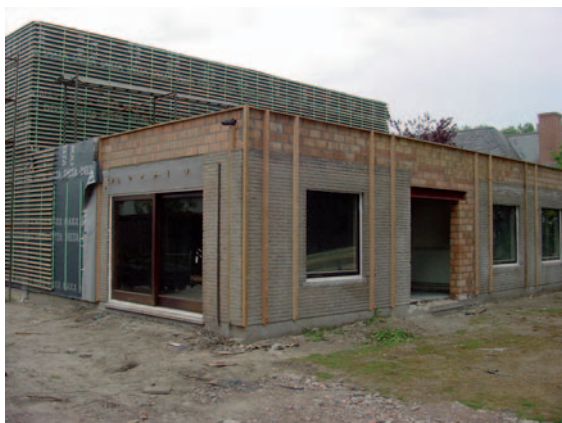
Fig. 57 Rénovation d'un bâtiment au moyen d'un bardage en tuiles (vues avant et après rénovation), lui offrant un aspect totalement neuf.
