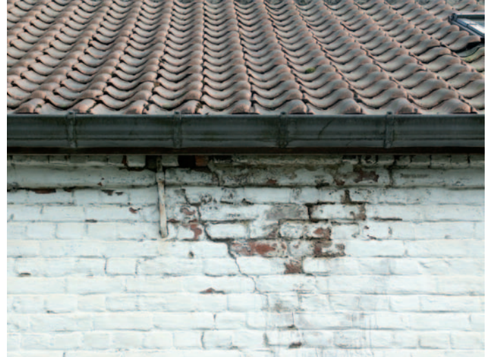
Fig. 52 Attaque de champignon en pied de versant ▲ Mur endommagé par des poussées latérales ►
