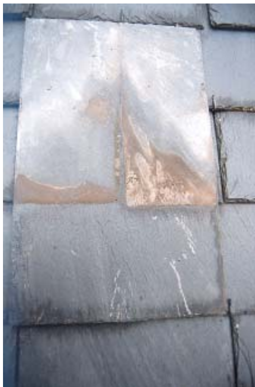
A. ZONE DE MOUILLAGE AVEC RECOUVREMENT BIEN CALCULÉ
