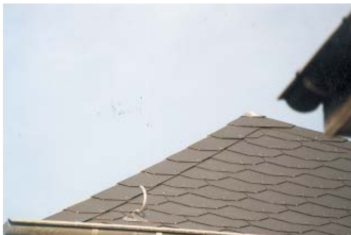
Fig. 71 Exemple d'arêtier en bardeli.
