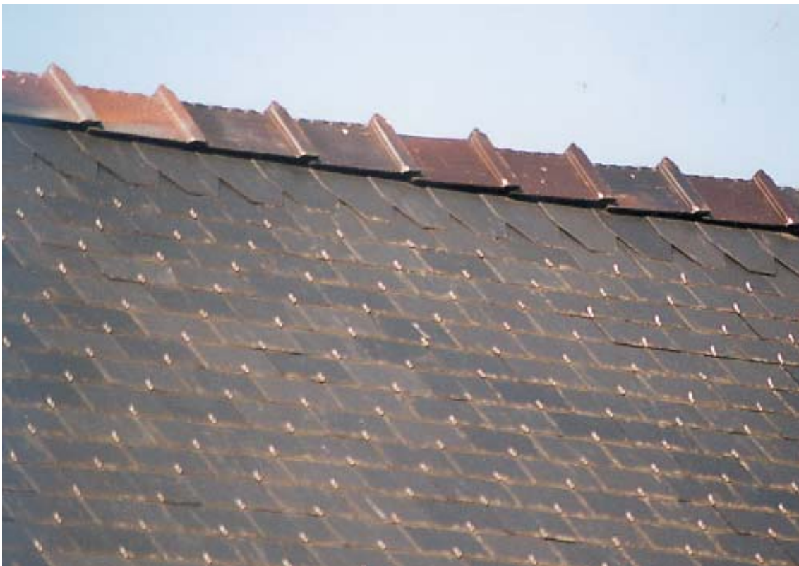
Fig. 84 Exemples de faitages en terre cuite.
