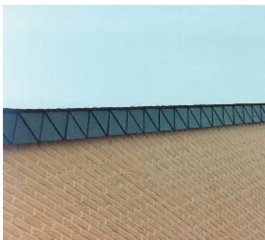
B. À RANG D'ARDOISES COUPÉES EN BIAIS
