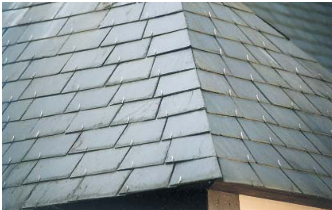
Fig. 63 Exemple d'un arêtier à deux biaises.
