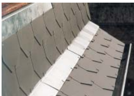
Fig. 52 Exemple de coyau avec bande métallique.
