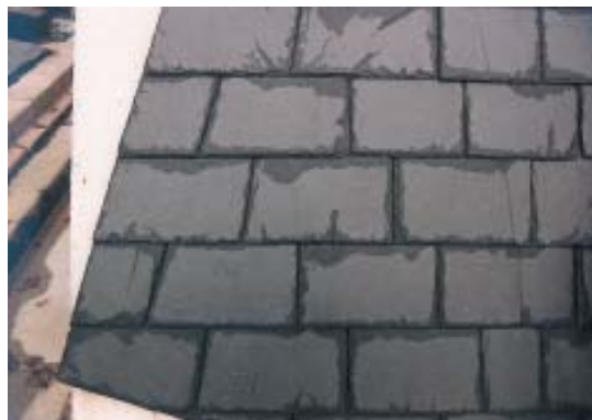
Fig. 58 Ardoises biaises dans un arêtier.
