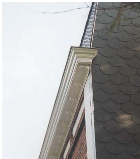
B. CORNICHE EN ENCORBELLEMENT
