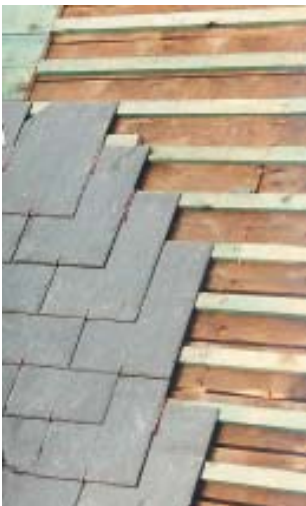
Fig. 6 Recouvrement des ardoises.
