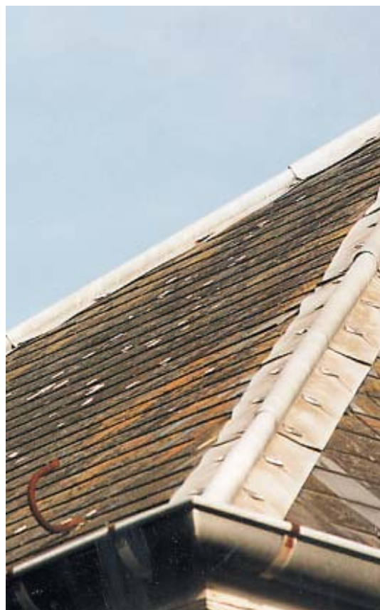
Fig. 76 Exemple d'arêtier métallique (avec tasseau).
