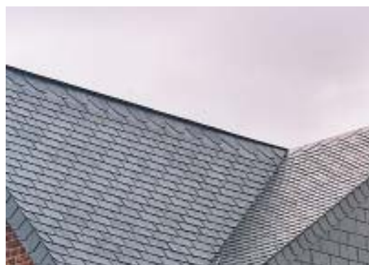
Fig. 81 Exemple de faîtage en lignolet.
