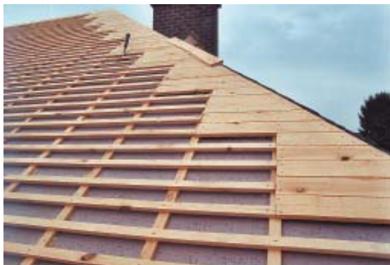
Fig. 57 Voligeage jointif le long de l'arêtier.
