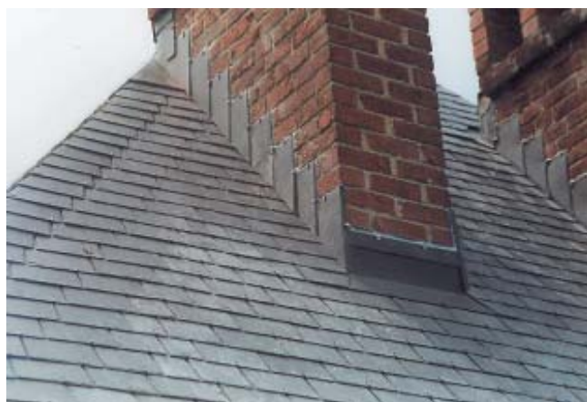
Fig. 95 Exemple de cheminée avec solins en gradin.
