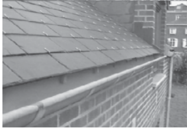
A. ÉGOUT DROIT – POSE AU CROCHET
