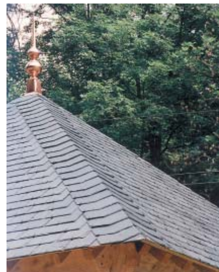
Fig. 69 Exemple d'arêtier à la belge.
