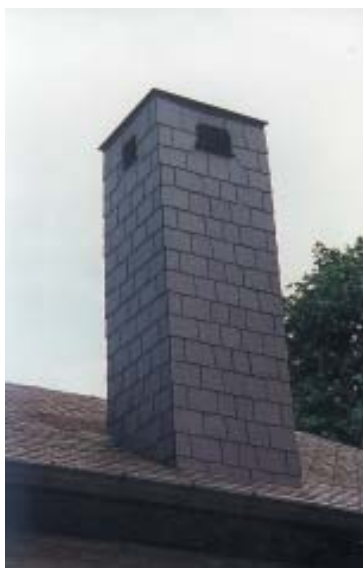
Fig. 96 Exemple de cheminée avec bardage en ardoises.
