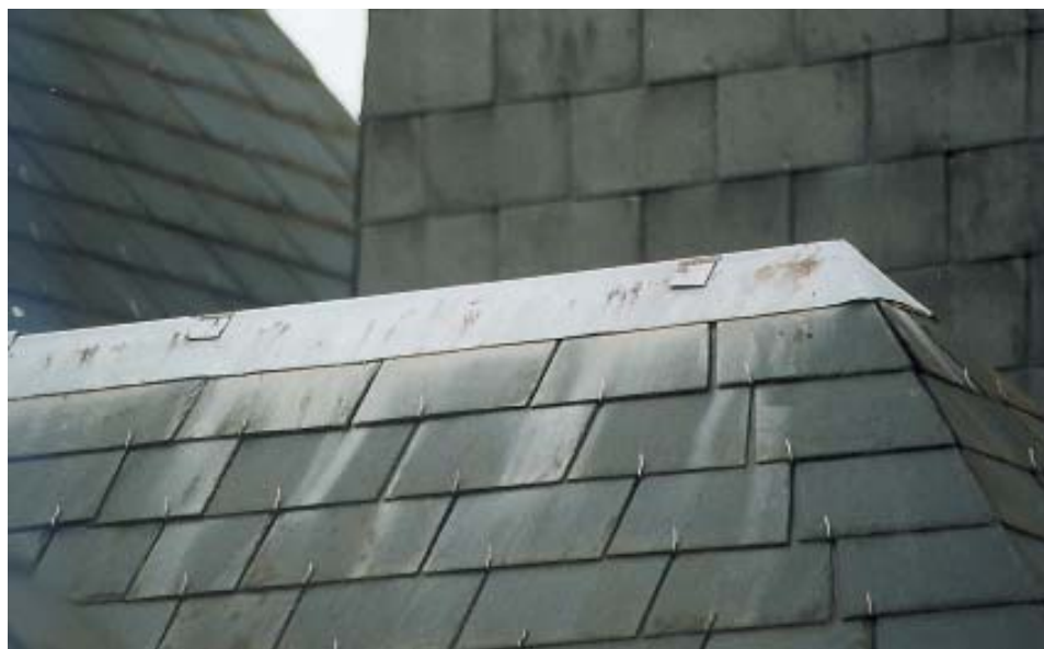
Fig. 87 Exemple de faitage métallique.
