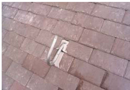
Fig. 29 Exemple d'un crochet de service.
